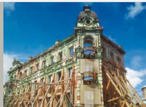
Реконструкция гостиницы «Казань»
